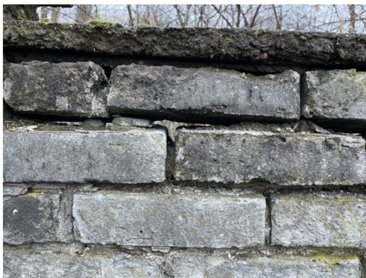
Fot. 19 Widok ścian i słupków ogrodzeniowych – od strony zachodniej
