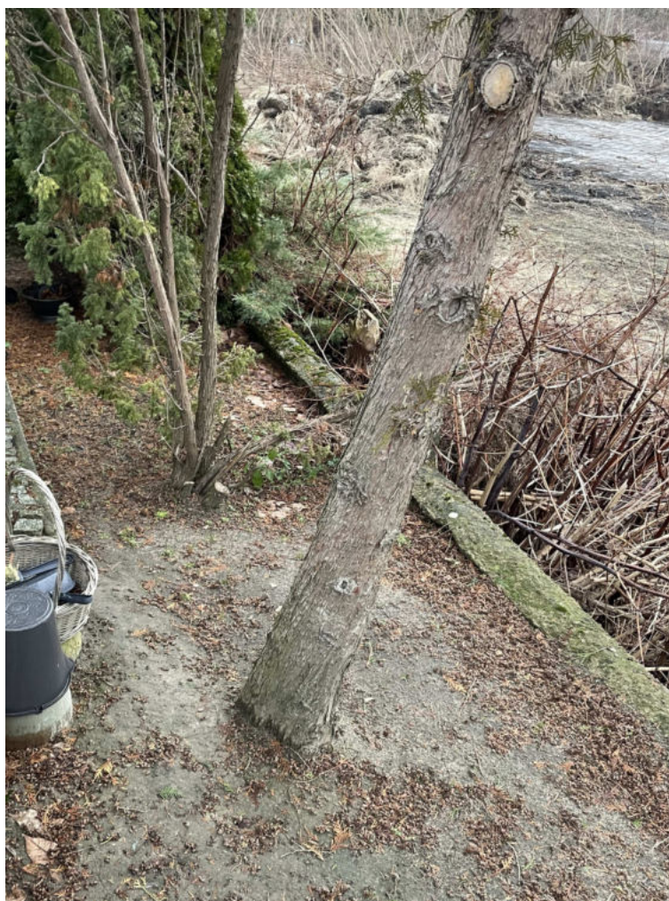
Fot. 15 Widok ścian i słupków ogrodzeniowych – od strony wschodniej
