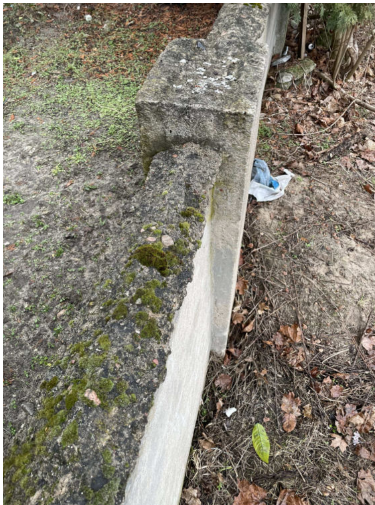
Fot. 12 Widok ścian i słupków ogrodzeniowych – od strony wschodniej
