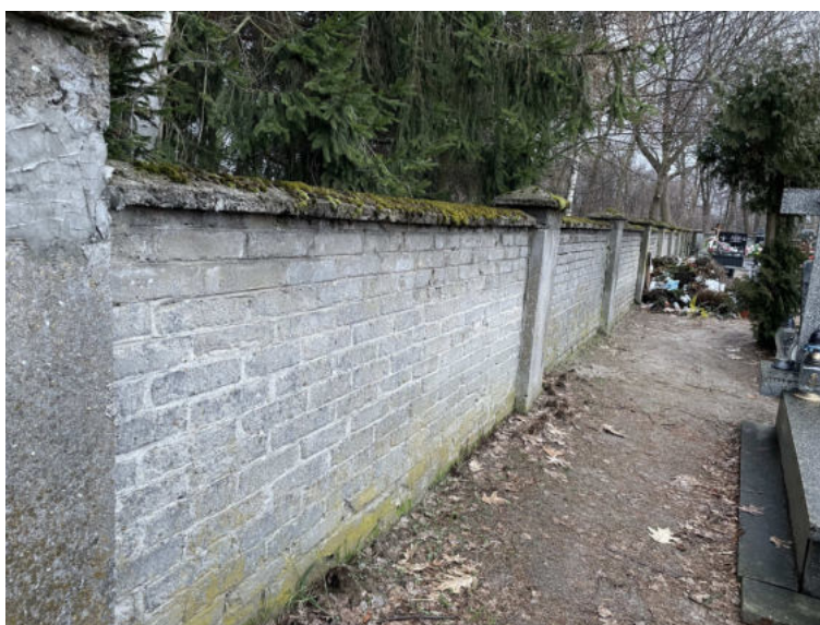
Fot. 16 Widok ścian i słupków ogrodzeniowych – od strony zachodniej
