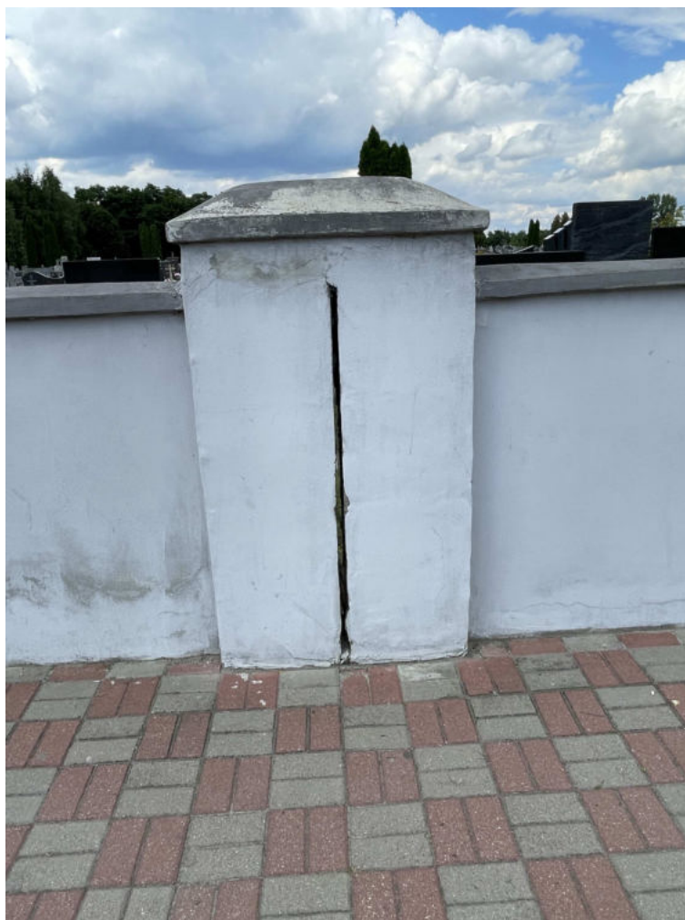
Fot. 2 Widok ścian i słupków ogrodzeniowych – część frontowa
