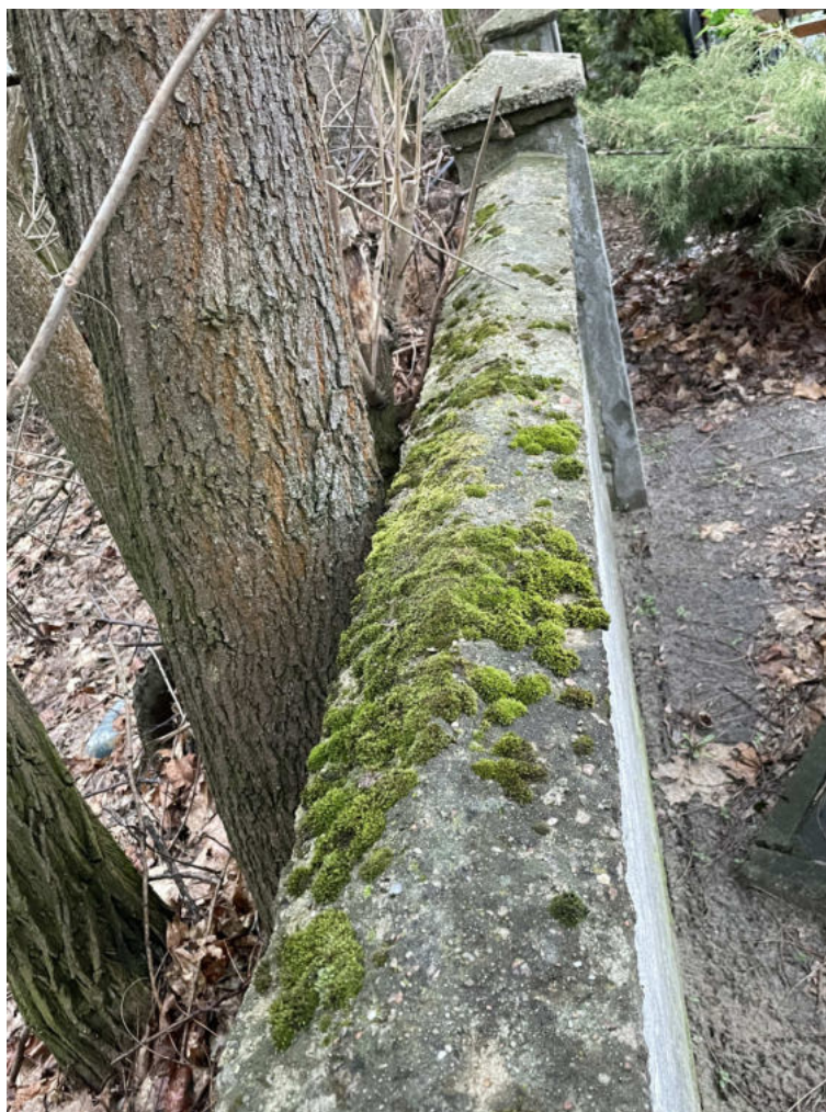
Fot. 10 Widok ścian i słupków ogrodzeniowych – od strony zachodniej
