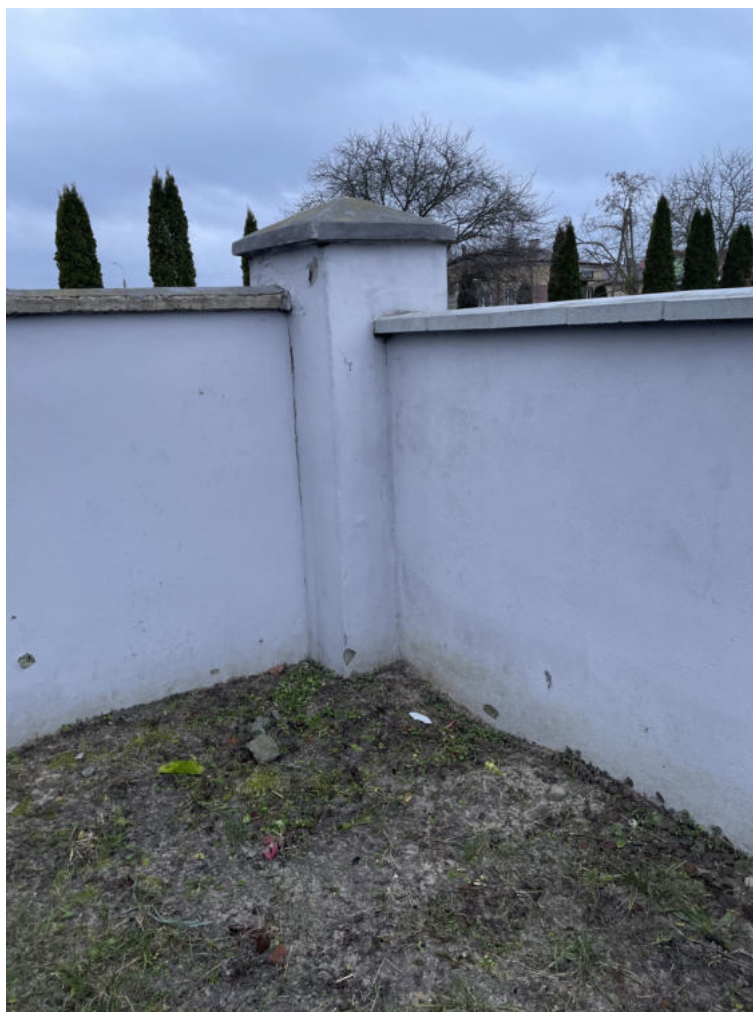
Fot. 7 Widok ścian i słupków ogrodzeniowych – część frontowa
