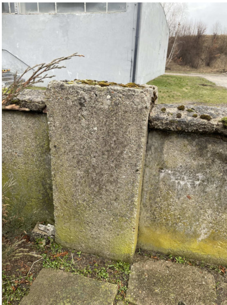
Fot. 10 Widok ścian i słupków ogrodzeniowych – od strony wschodniej
