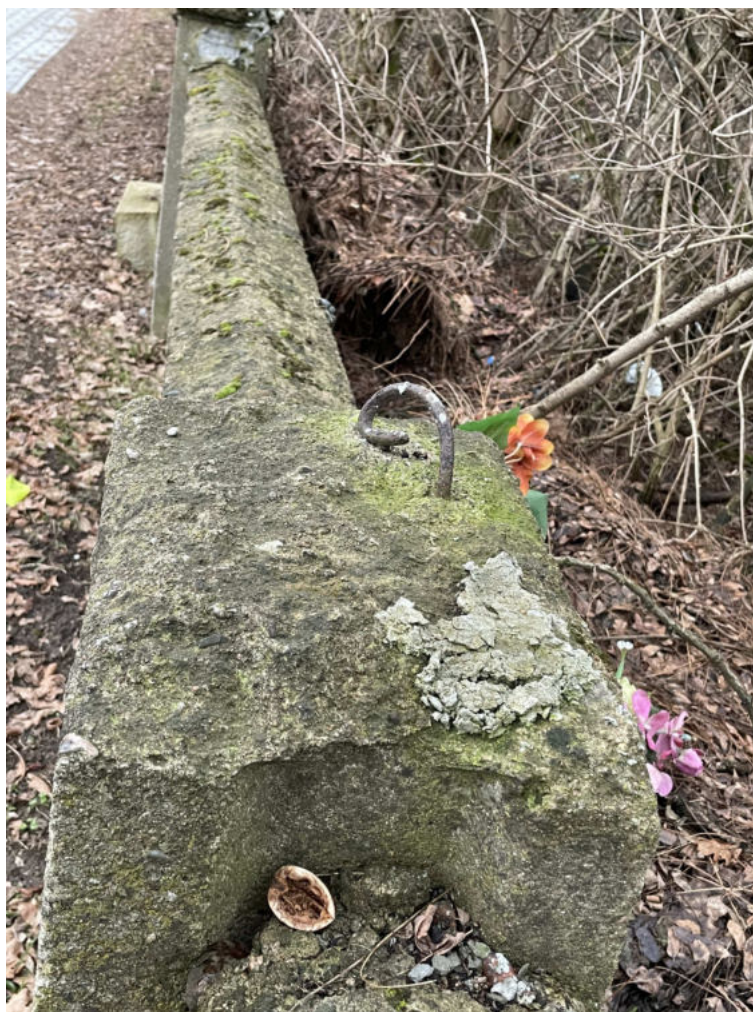
Fot. 13 Widok ścian i słupków ogrodzeniowych – od strony zachodniej
