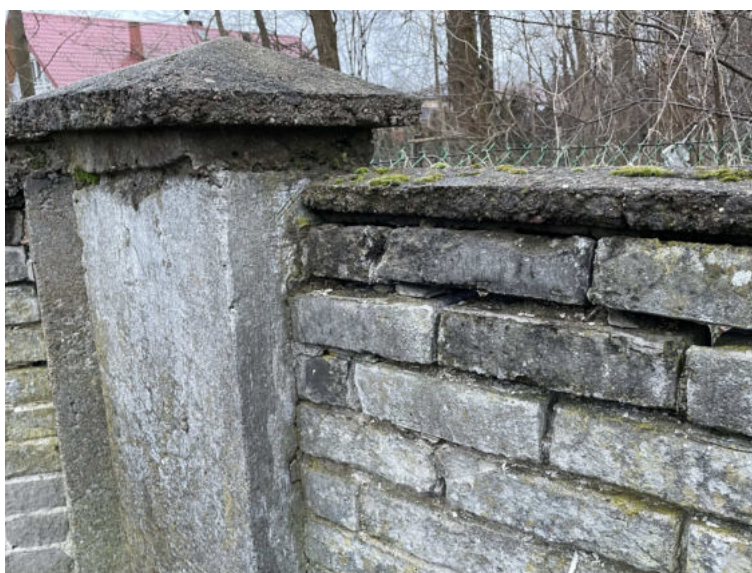
Fot. 18 Widok ścian i słupków ogrodzeniowych – od strony zachodniej
