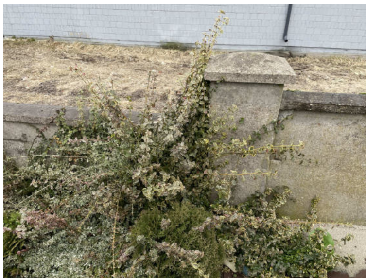
Fot. 4 Widok ścian i słupków ogrodzeniowych – od strony wschodniej
