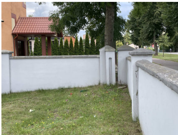
Fot. 4 Widok ścian i słupków ogrodzeniowych – część frontowa
