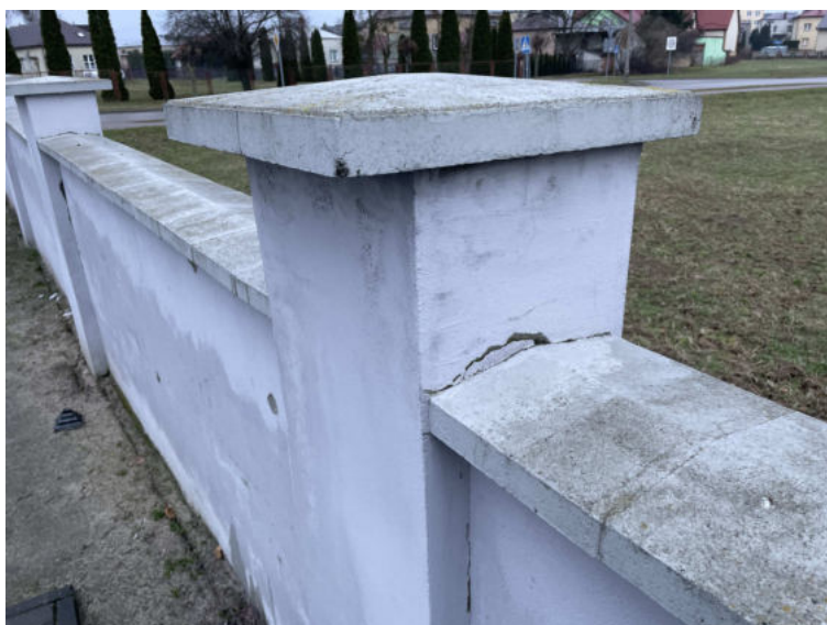
Fot. 3 Widok ścian i słupków ogrodzeniowych – od strony zachodniej
