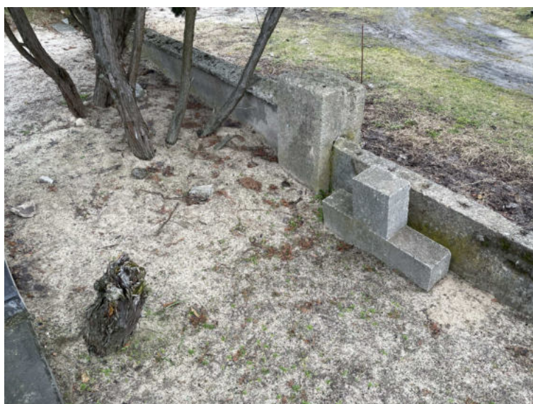
Fot. 11 Widok ścian i słupków ogrodzeniowych – od strony wschodniej
