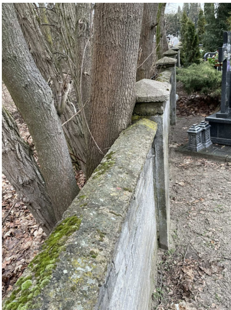
Fot. 9 Widok ścian i słupków ogrodzeniowych – od strony zachodniej
