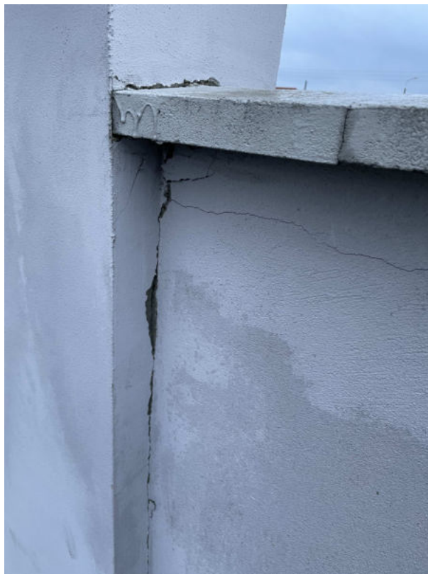
Fot. 4 Widok ścian i słupków ogrodzeniowych – od strony zachodniej
