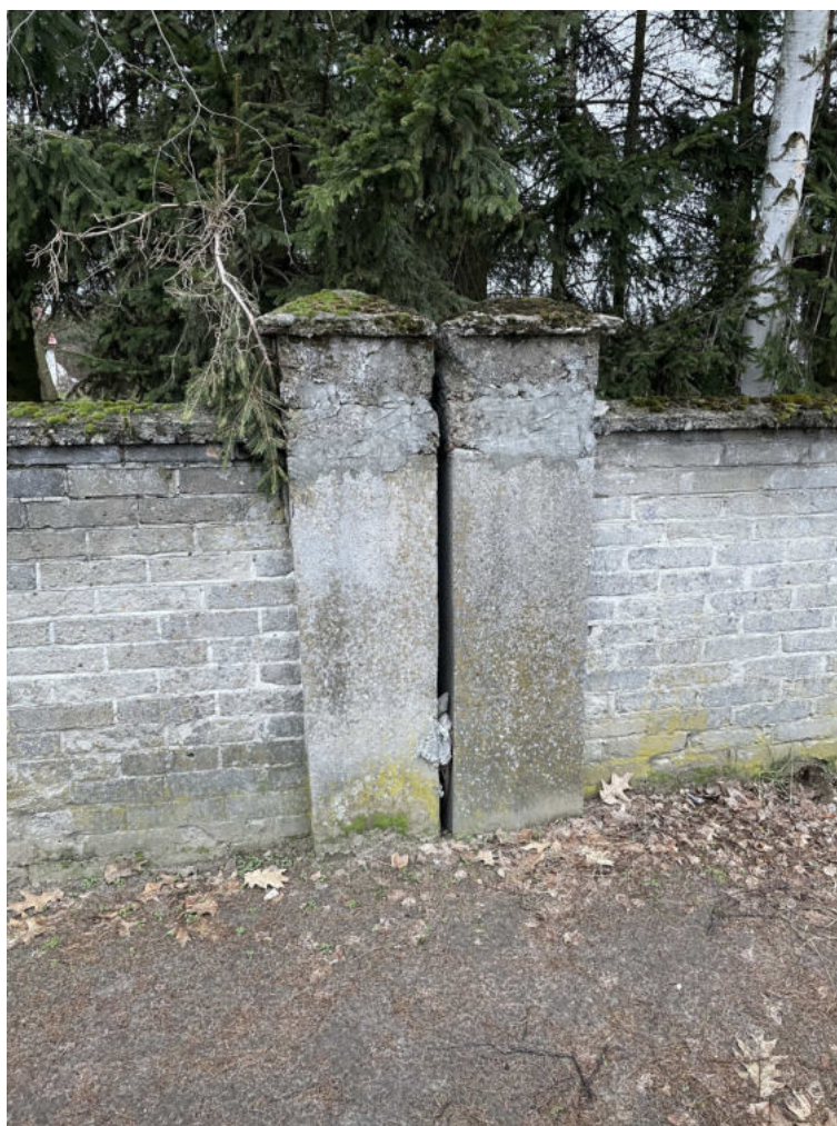
Fot. 22 Widok ścian i słupków ogrodzeniowych – od strony zachodniej
