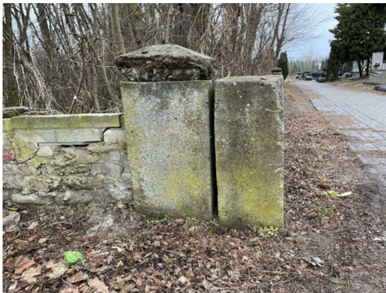
Fot. 11 Widok ścian i słupków ogrodzeniowych – od strony zachodniej
