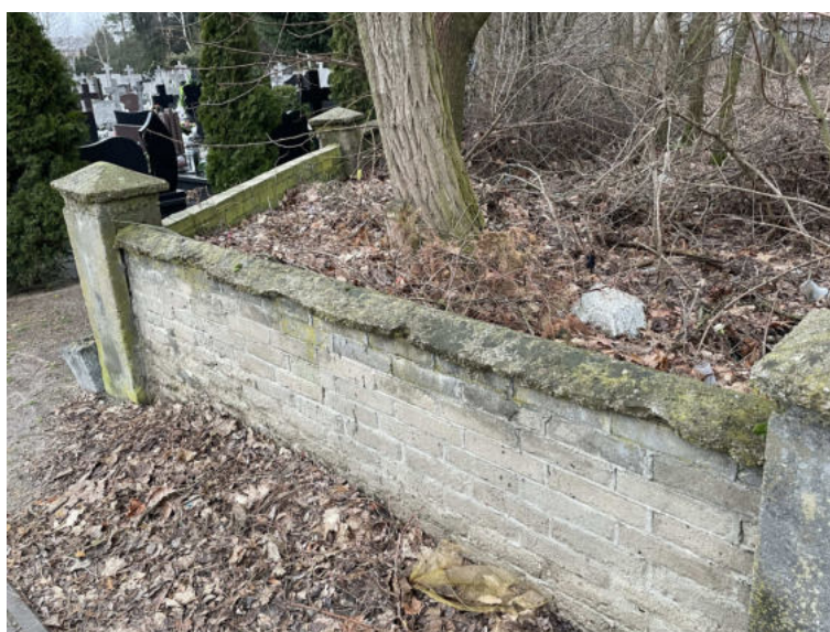
Fot. 7 Widok ścian i słupków ogrodzeniowych – od strony zachodniej
