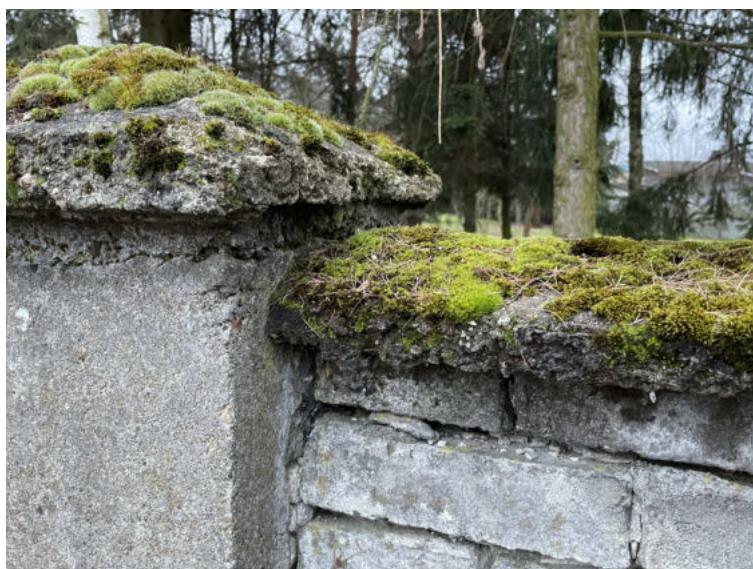
Fot. 20 Widok ścian i słupków ogrodzeniowych – od strony zachodniej
