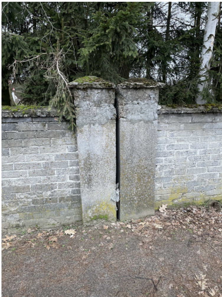
Fot. 15 Widok ścian i słupków ogrodzeniowych – od strony zachodniej
