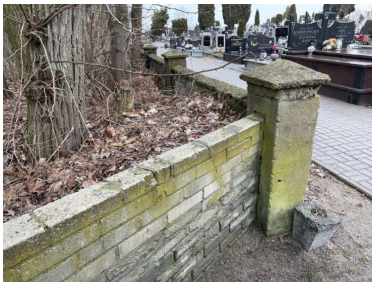
Fot. 8 Widok ścian i słupków ogrodzeniowych – od strony zachodniej
