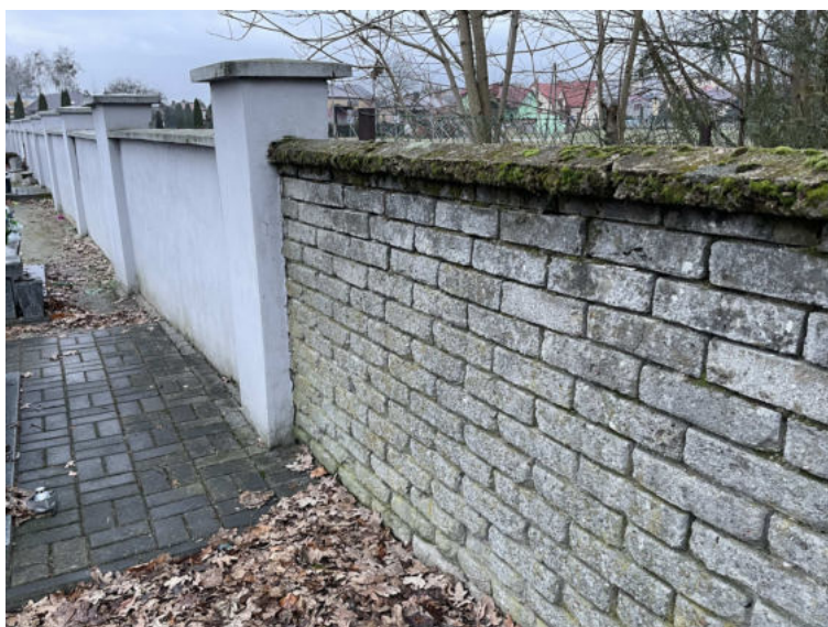
Fot. 34 Widok ścian i słupków ogrodzeniowych – od strony zachodniej
