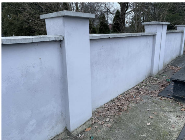
Fot. 1 Widok ścian i słupków ogrodzeniowych – od strony zachodniej
