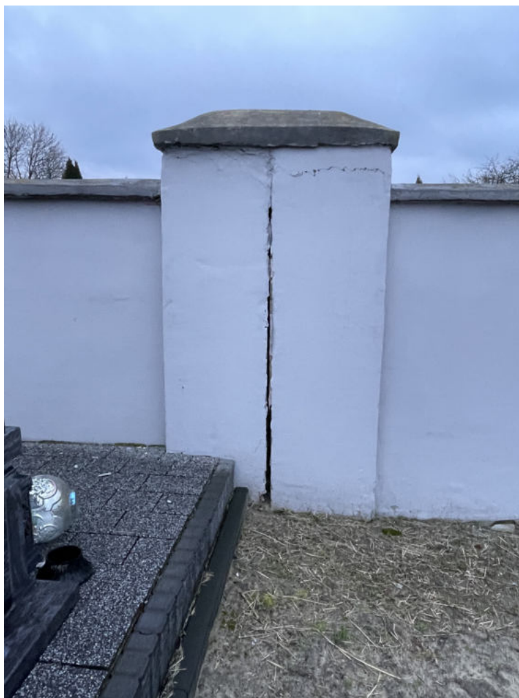
Fot. 8 Widok ścian i słupków ogrodzeniowych – część frontowa
