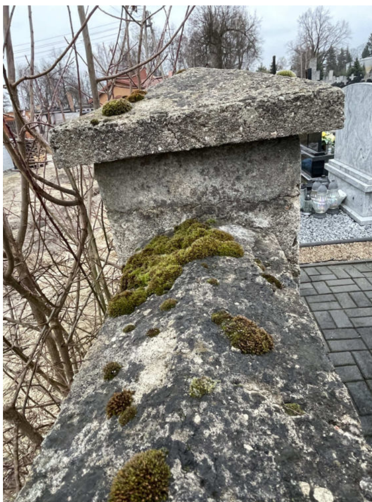
Fot. 5 Widok ścian i słupków ogrodzeniowych – od strony wschodniej
