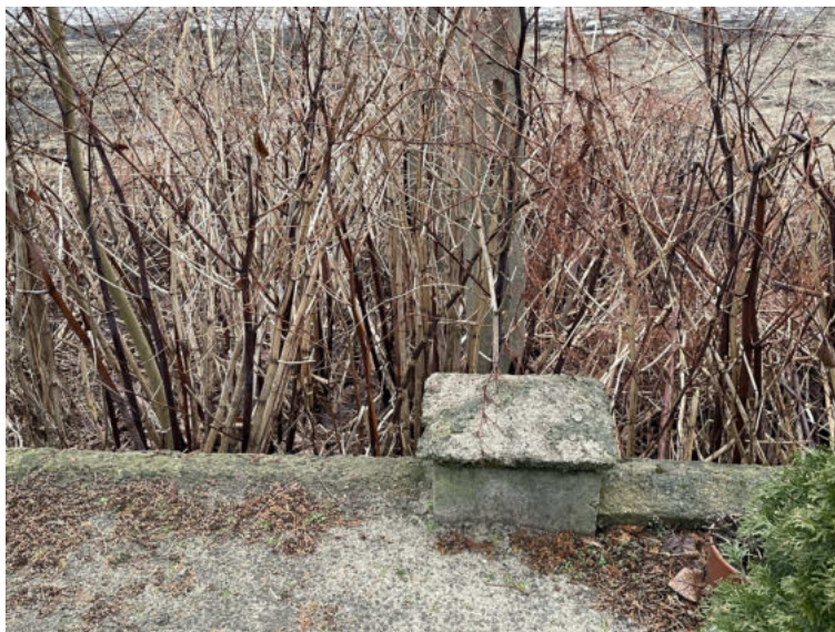
Fot. 16 Widok ścian i słupków ogrodzeniowych – od strony wschodniej
