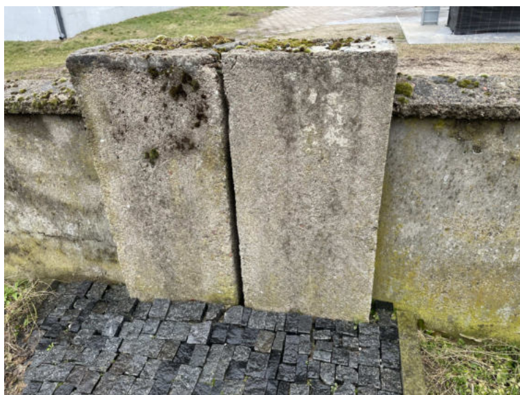
Fot. 9 Widok ścian i słupków ogrodzeniowych z dylatacją – od strony wschodniej
