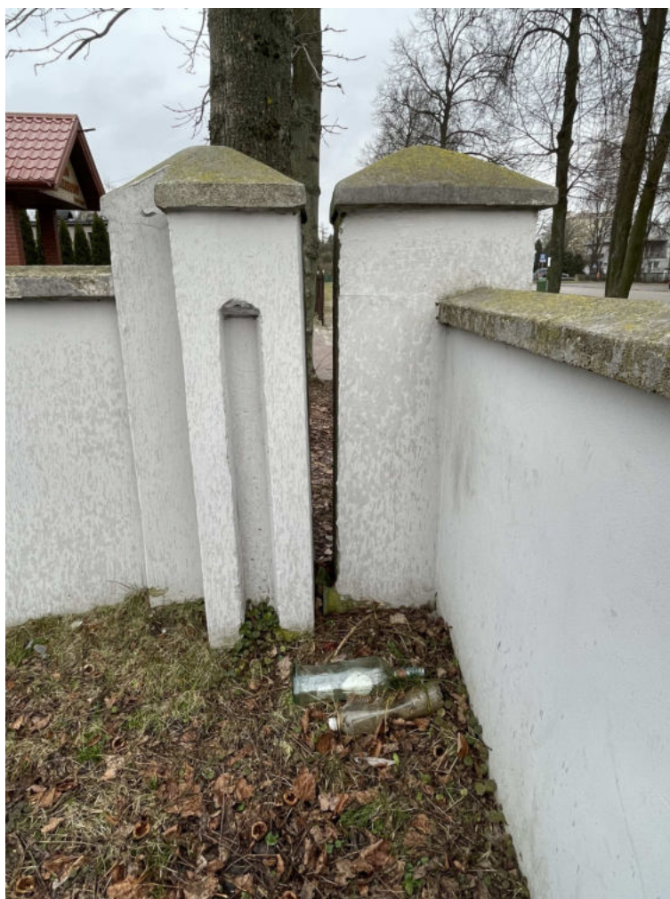
Fot. 5 Widok ścian i słupków ogrodzeniowych – część frontowa
