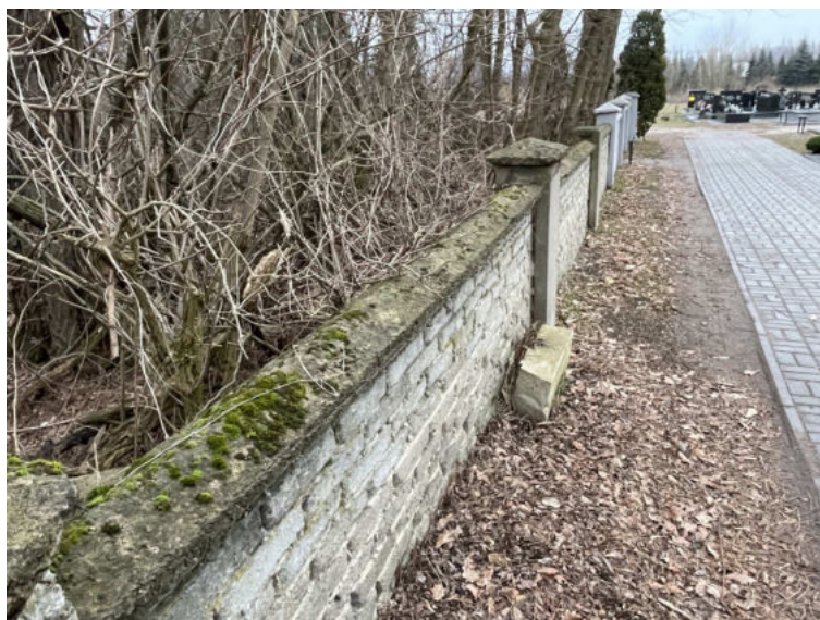
Fot. 1 Widok ścian i słupków ogrodzeniowych – od strony zachodnie
