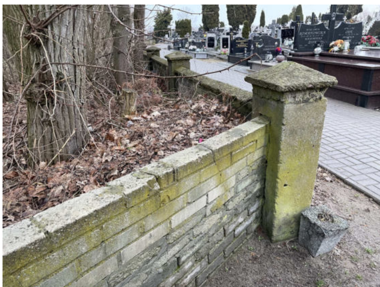
Fot. 12 Widok ścian i słupków ogrodzeniowych – od strony zachodniej
