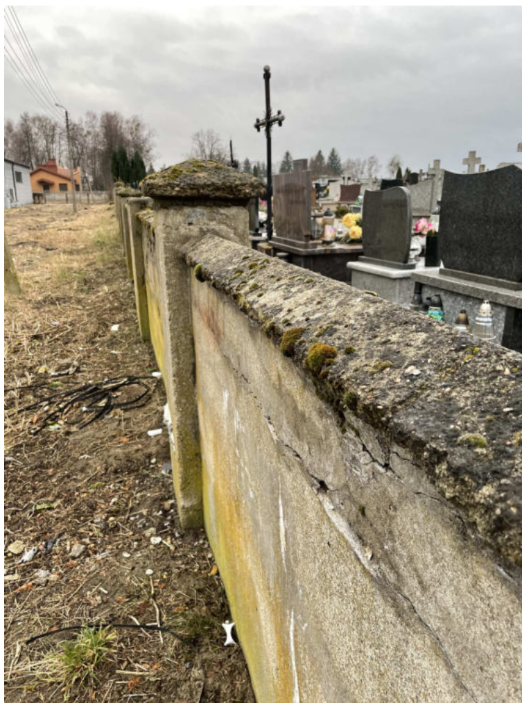
Fot. 8 Widok ścian i słupków ogrodzeniowych – od strony wschodniej
