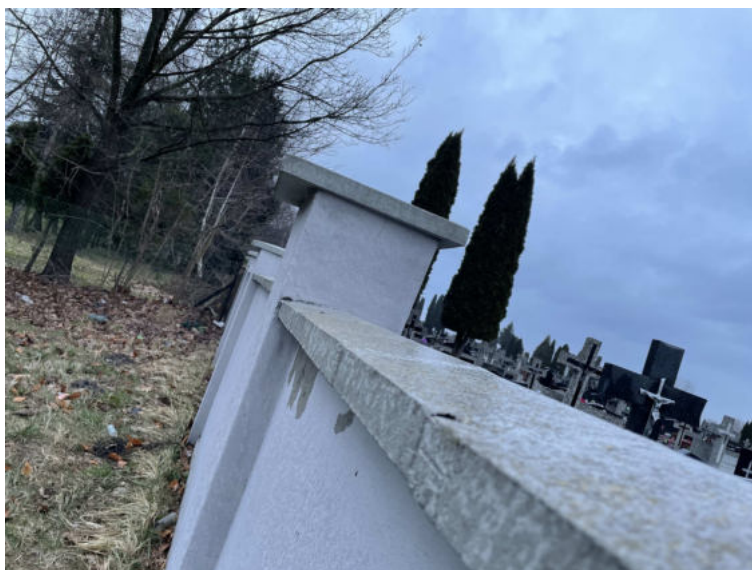
Fot. 2 Widok ścian i słupków ogrodzeniowych – od strony zachodniej
