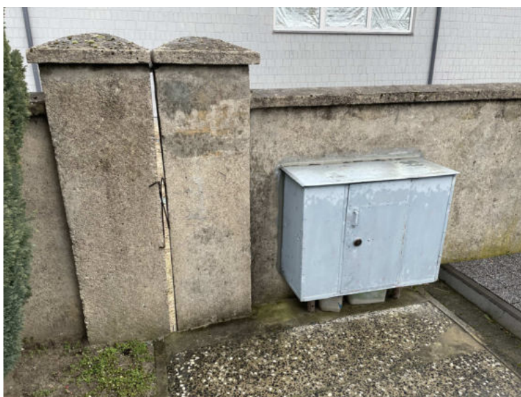
Fot. 3 Widok ścian i słupków ogrodzeniowych z dylatacją – od strony wschodniej
