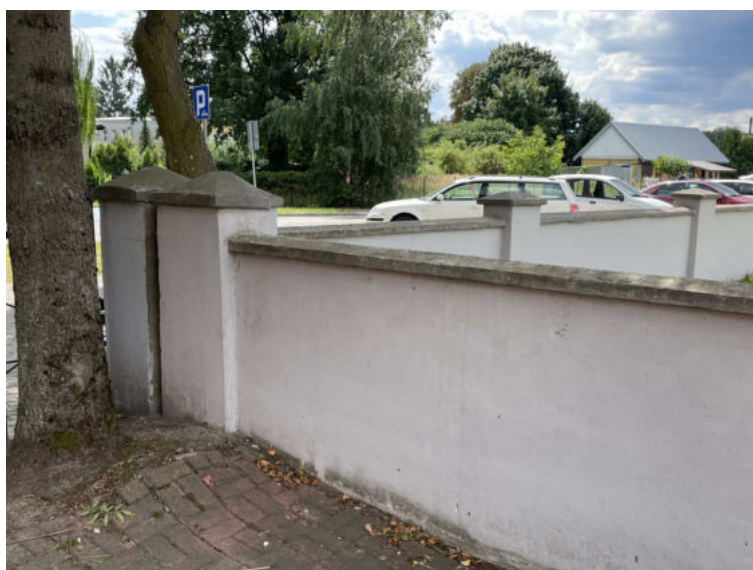
Fot. 3 Widok ścian i słupków ogrodzeniowych
