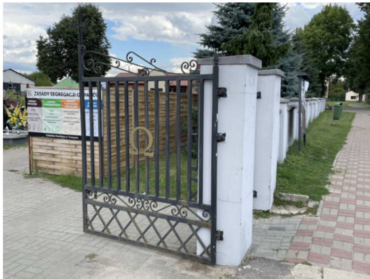
Fot. 2 Widok metalowej bramy i słupków ogrodzeniowych
