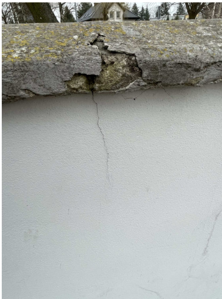
Fot. 11 Widok ścian i słupków ogrodzeniowych – część frontowa
