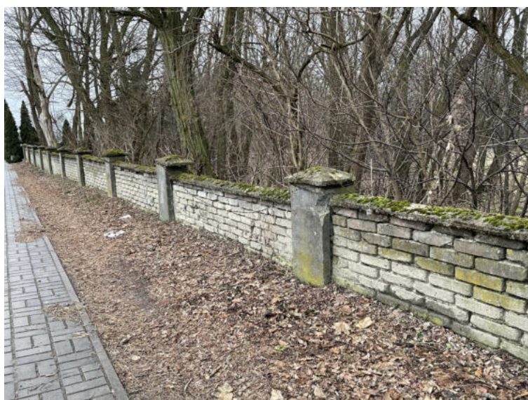
Fot. 7 Widok ścian i słupków ogrodzeniowych – od strony zachodniej
