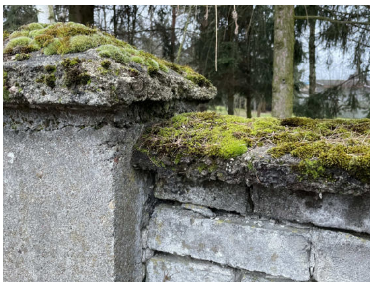
Fot. 14 Widok ścian i słupków ogrodzeniowych – od strony zachodniej
