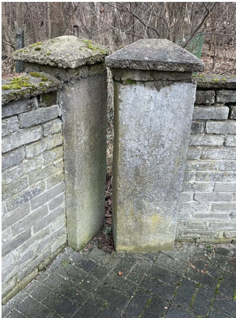
Fot. 17 Widok ścian i słupków ogrodzeniowych – od strony zachodniej
