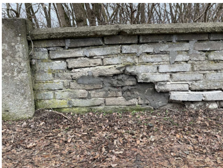
Fot. 9 Widok ścian i słupków ogrodzeniowych – od strony zachodniej
