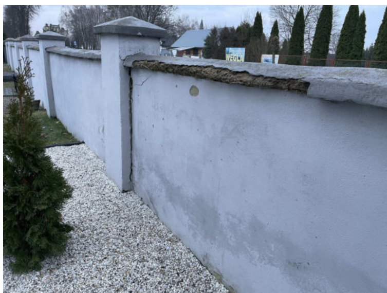
Fot. 9 Widok ścian i słupków ogrodzeniowych – część frontowa
