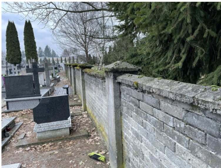
Fot. 23 Widok ścian i słupków ogrodzeniowych – od strony zachodniej
