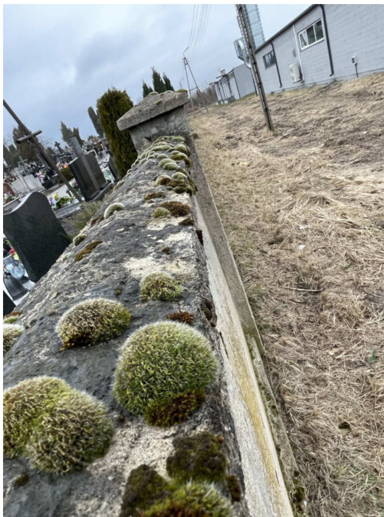
Fot. 6 Widok ścian i słupków ogrodzeniowych – od strony wschodniej
