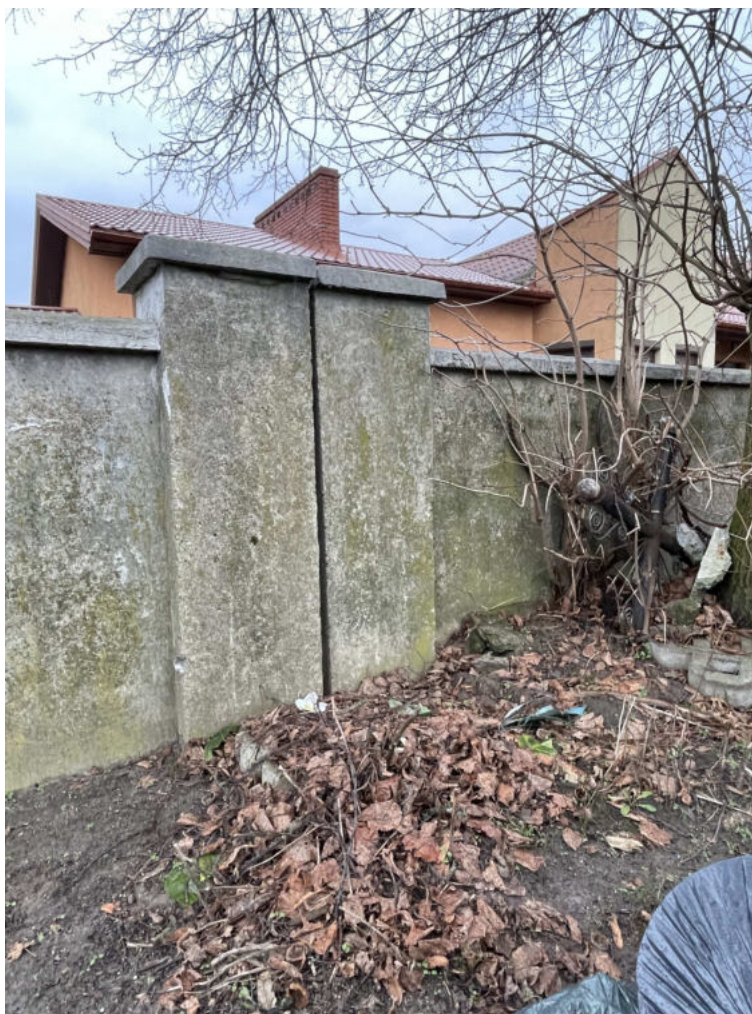
Fot. 2 Widok ścian i słupków ogrodzeniowych z dylatacją – od strony wschodniej
