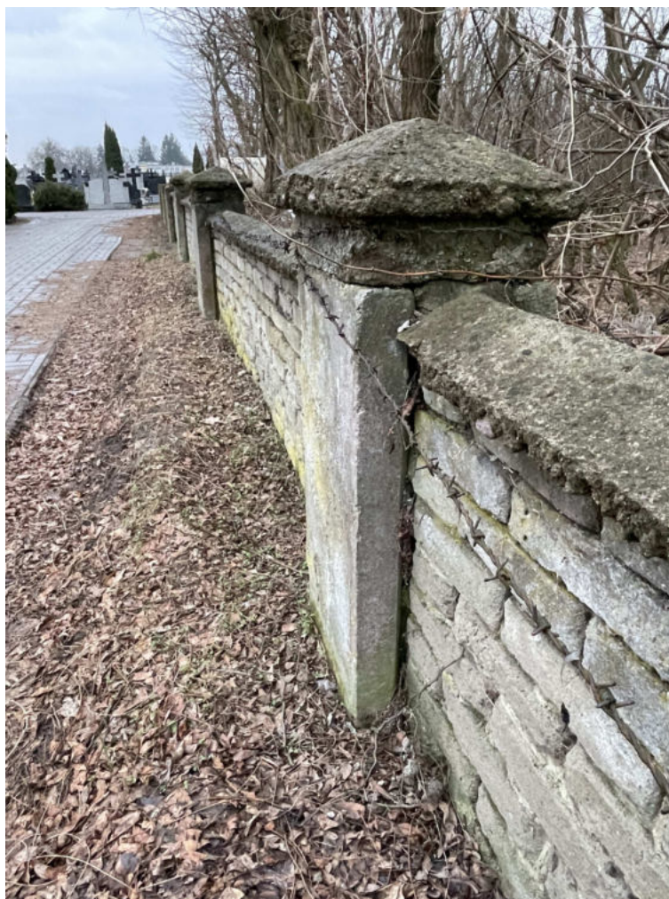
Fot. 6 Widok ścian i słupków ogrodzeniowych – od strony zachodniej
