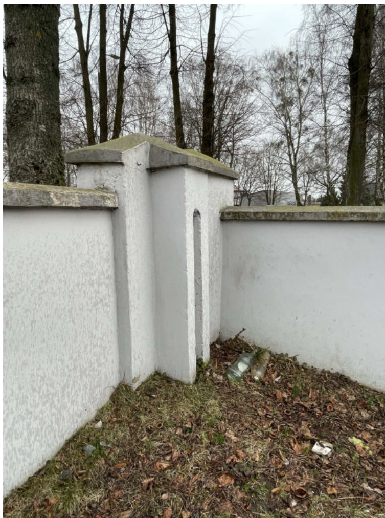
Fot. 6 Widok ścian i słupków ogrodzeniowych – część frontowa
