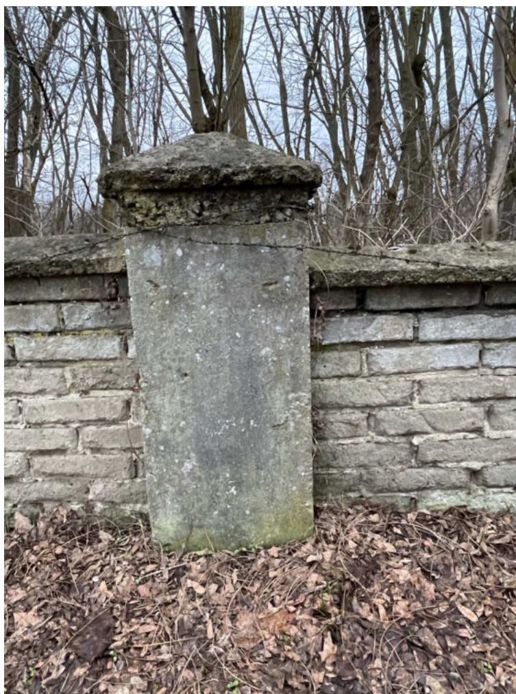
Fot. 5 Widok ścian i słupków ogrodzeniowych – od strony zachodniej
