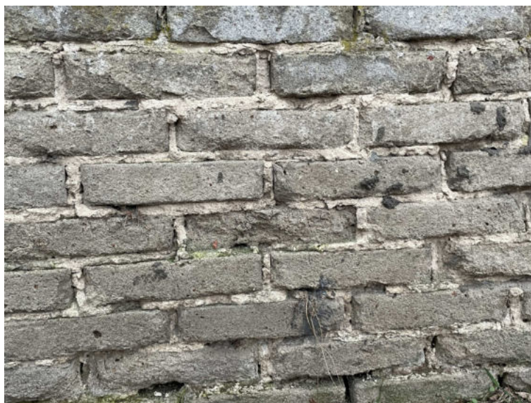
Fot. 3 Widok ścian i słupków ogrodzeniowych – od strony zachodniej
