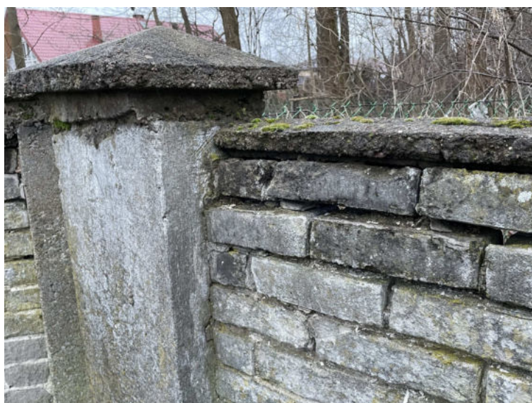
Fot. 10 Widok ścian i słupków ogrodzeniowych – od strony zachodniej
