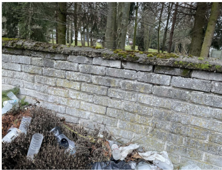
Fot. 21 Widok ścian i słupków ogrodzeniowych – od strony zachodniej
