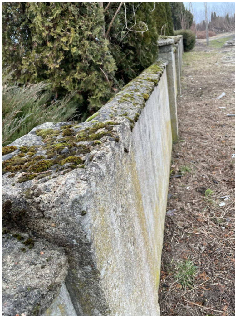
Fot. 7 Widok ścian i słupków ogrodzeniowych – od strony wschodniej
