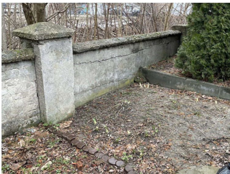
Fot. 17 Widok ścian i słupków ogrodzeniowych – od strony wschodniej
