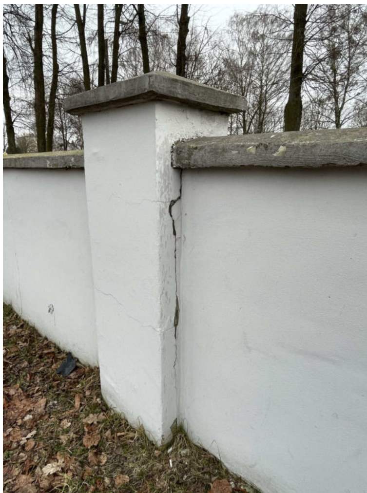
Fot. 10 Widok ścian i słupków ogrodzeniowych – część frontowa
