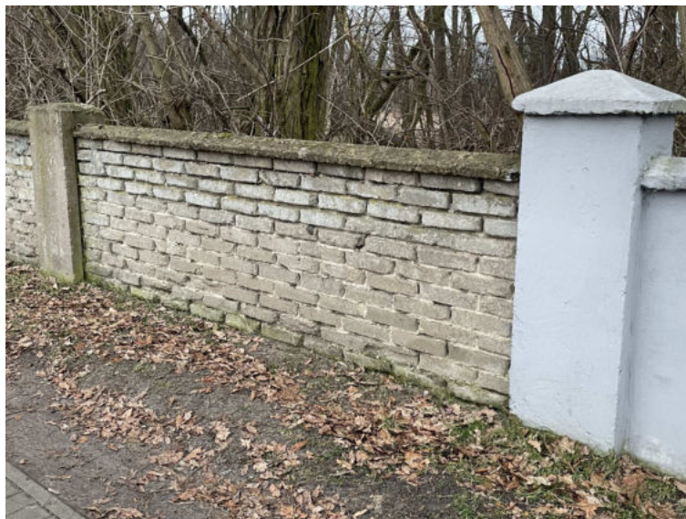
Fot. 1 Widok ścian i słupków ogrodzeniowych – od strony zachodniej
