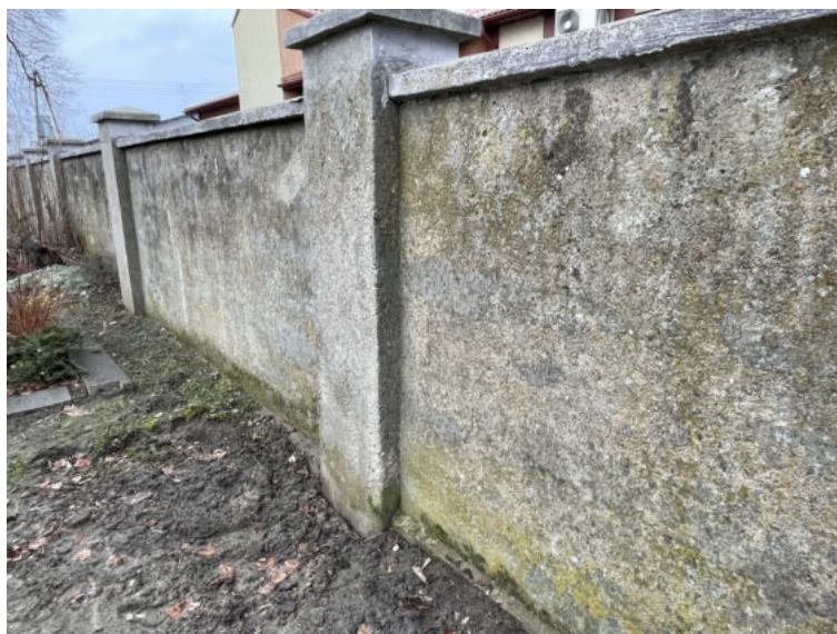
Fot. 1 Widok ścian i słupków ogrodzeniowych – od strony wschodniej
