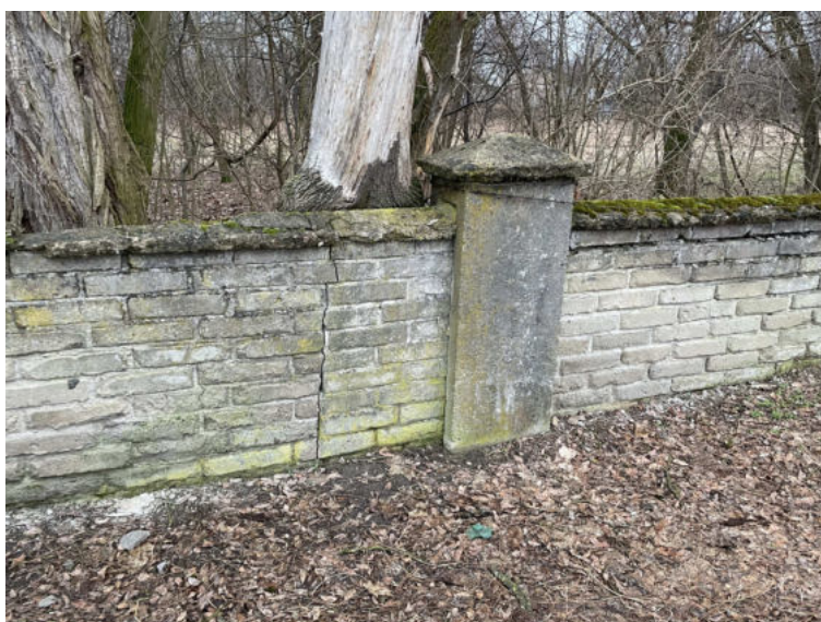
Fot. 5 Widok ścian i słupków ogrodzeniowych – od strony zachodniej
