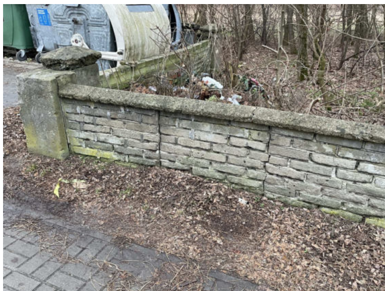
Fot. 8 Widok ścian i słupków ogrodzeniowych – od strony zachodniej
